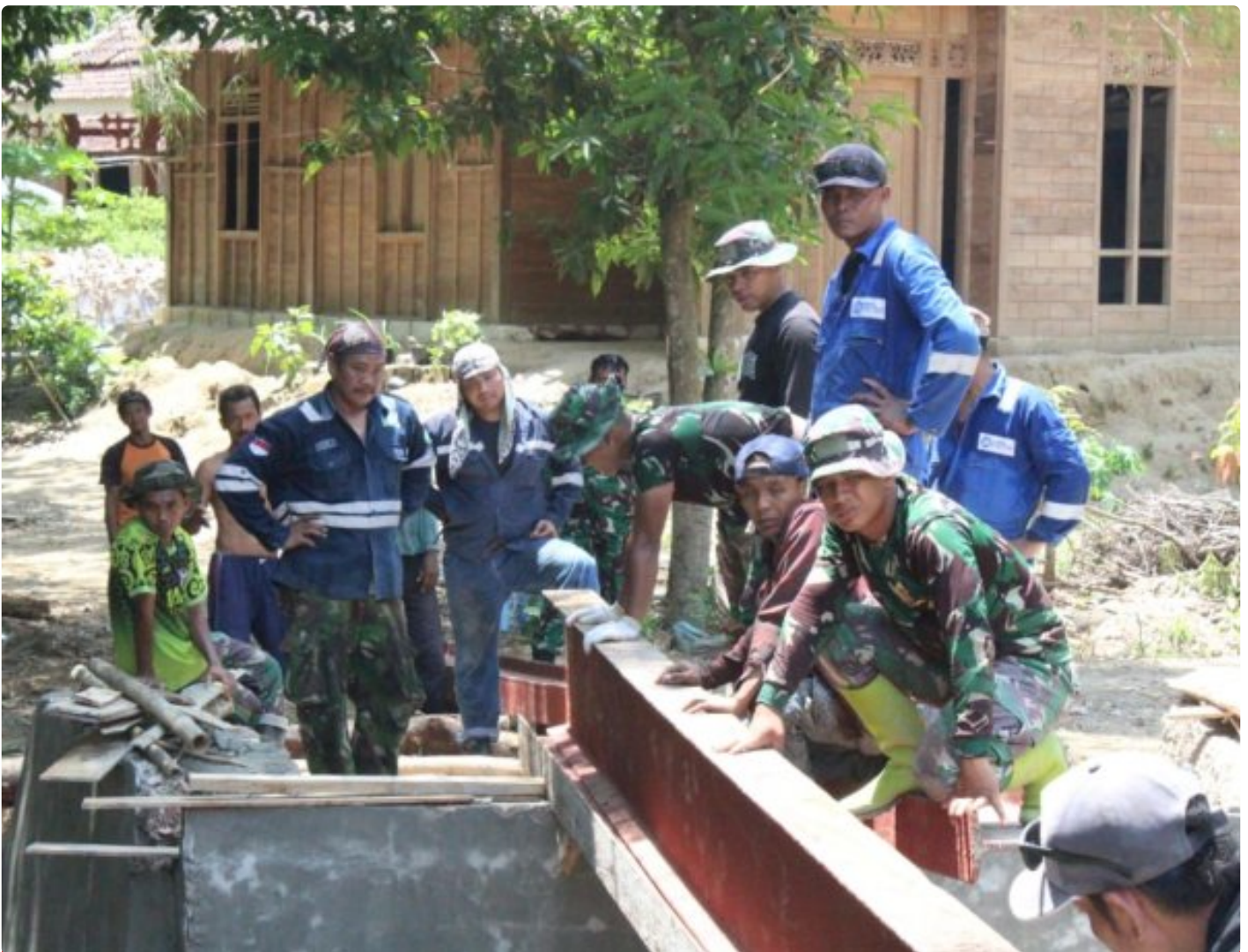
Foto: Anggota Satgas TMMD Reg 122 Kodim 0721/Blora Melaksanakan Pekerjaan Pembangunan Jembatan.
